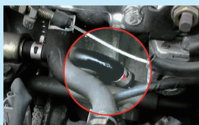
亀裂から燃料漏れをおこした燃料ホース
